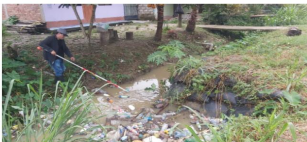
FIGURA N°02.- TRAMO CRITICO DE LA QUEBRADA NAVARRO QUE PASA POR LA CIUDAD, DONDE SE MUESTRA LA QUEBRADA CON SU CAUCE COLMATADO, GENERANDO EN EPOCAS DE LLUVIAS EL DESBORDE E INUNDANDO A LAS VIVIENDAS CERCANES AL CAUCE.
